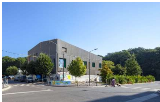
Légumerie et restaurant solidaire - La Passerelle Clichy-sous-Bois (93)
