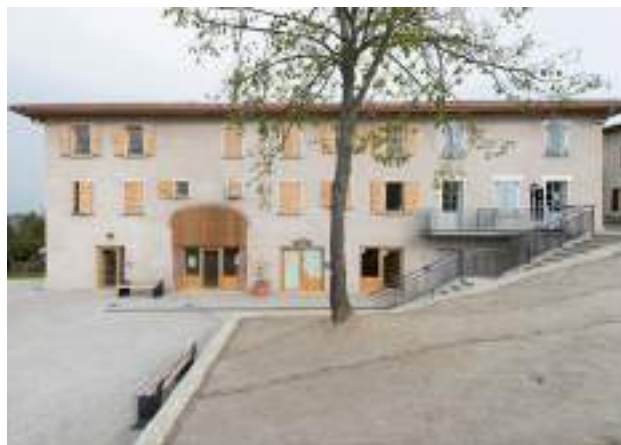
© V. Rigassi – Logements sociaux et commerces – Montseveroux (38)
