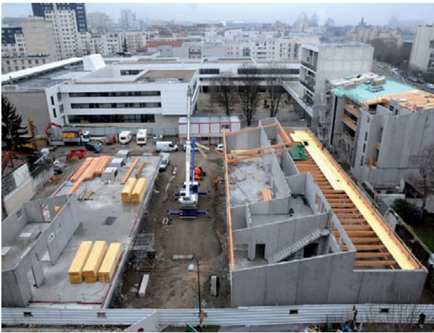
Avancement du chantier (janvier 2010) Photo : Bernard Vaillant
