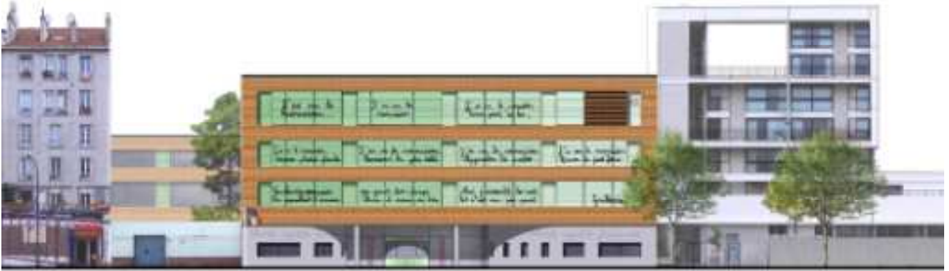
Façade Nord du bâtiment A sur le quai – bardage neuf avec les stores sérigraphiés descendus
