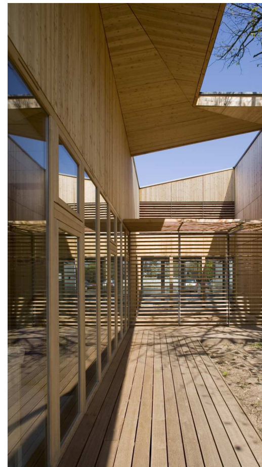
Unité psychiatrique pour mère et enfants à Brumath (67) Architectes : Atelier Zündel & Cristea BET : SIRR Ingénierie - Charpente bois : Gasser (67)
